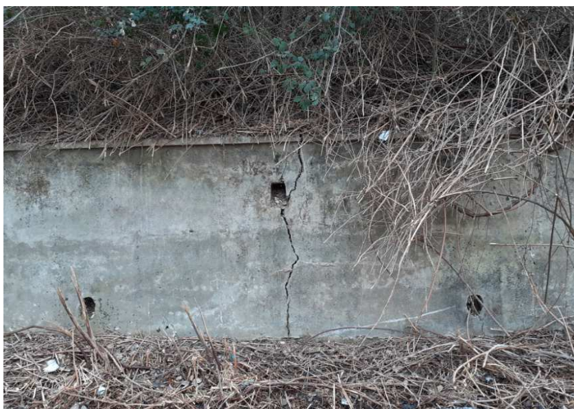
MURO DI SOTTOSCARPA FESSURATO- LATO NORD
