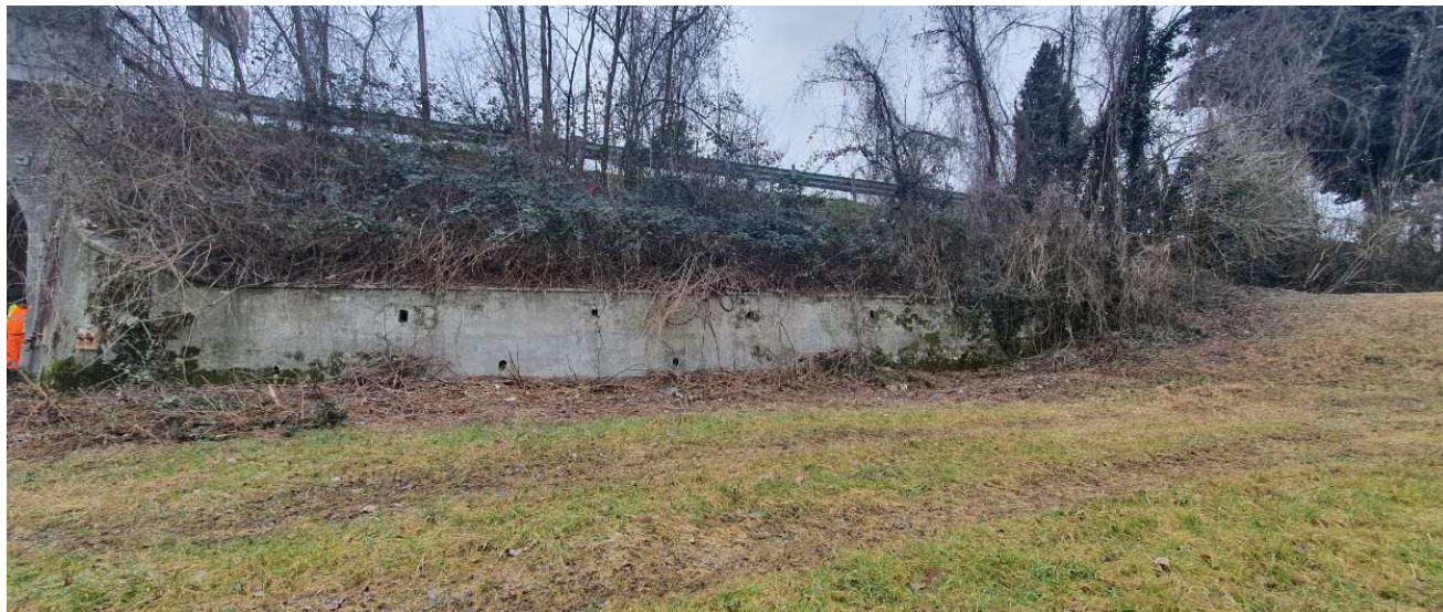
MURO DI SOTTOSCARPA LATO NORD CHE SI INNESTA NELL' ARGINE
