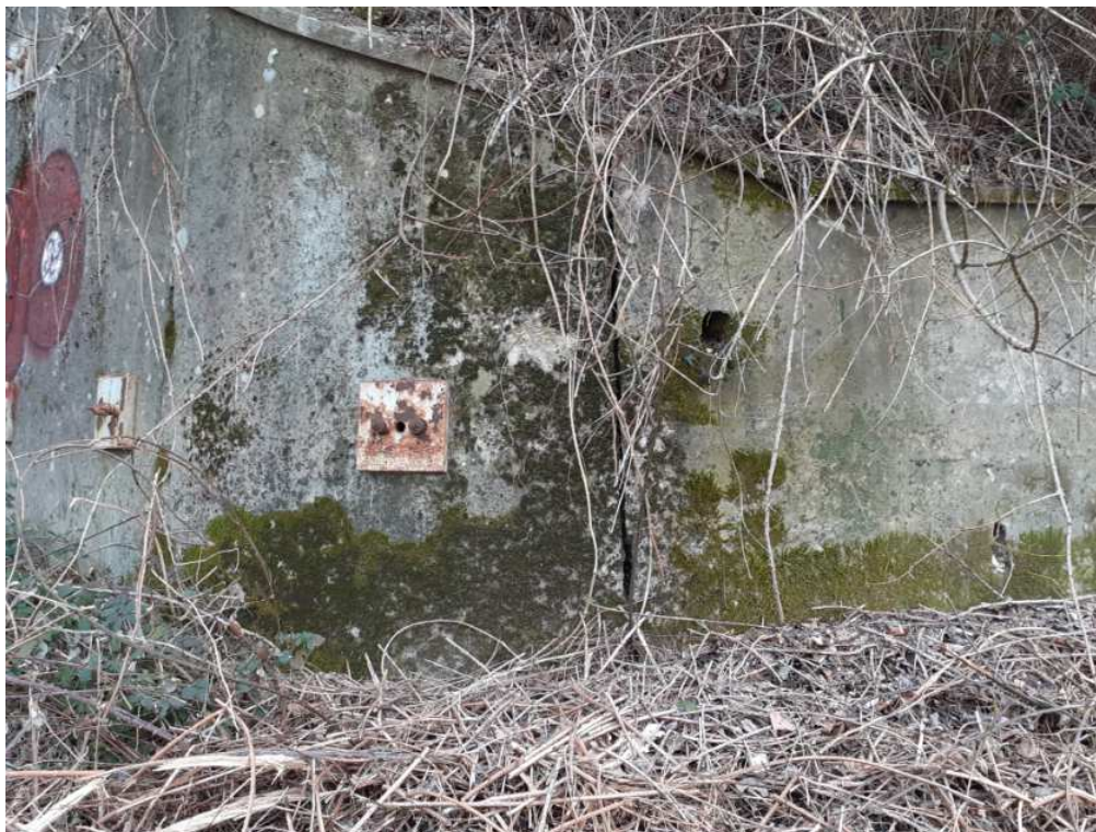
GIUNTO TECNICO DA RIPRISTINARE- LATO NORD
