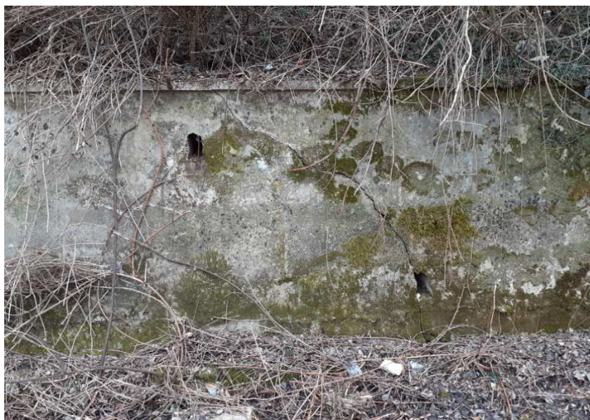
MURO DI SOTTOSCARPA FESSURATO- LATO NORD
